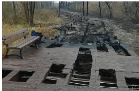
Rys. 20. Zniszczenia po pożarze.
